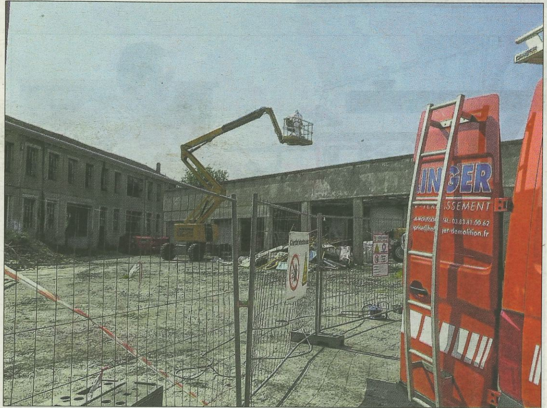
Les travaux préparatoires à la démolition de l'ancien Centre technique municipal ont débuté, il y a quelques semaines. Photo ER/Emmanuel VACCARO
