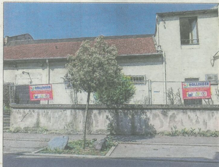
Des travaux préparatoires sont effectués sur l'îlot pressenti pour devenir une résidence seniors. Photo ER/Emmanuel VACCARO
