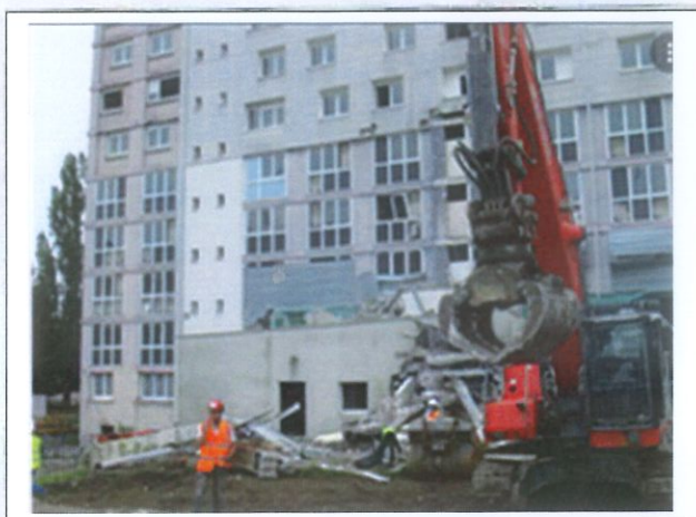
Un bras de 25 m est utilisé pour la déconstruction des bâtiments Bretagne et Normandie. Photo ER
