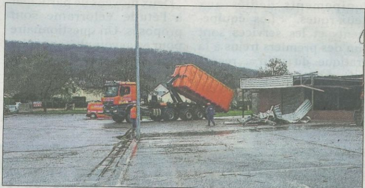
Tous les éléments de construction font l'objet d'un tri minutieux afin de les valoriser.
