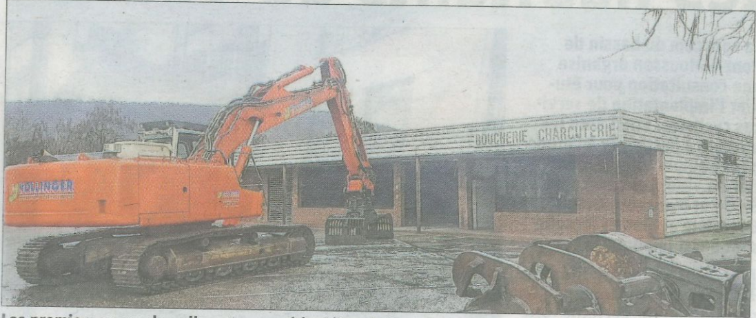
Les premiers coups de pelle ont marqué le début de la destruction du bâtiment.
