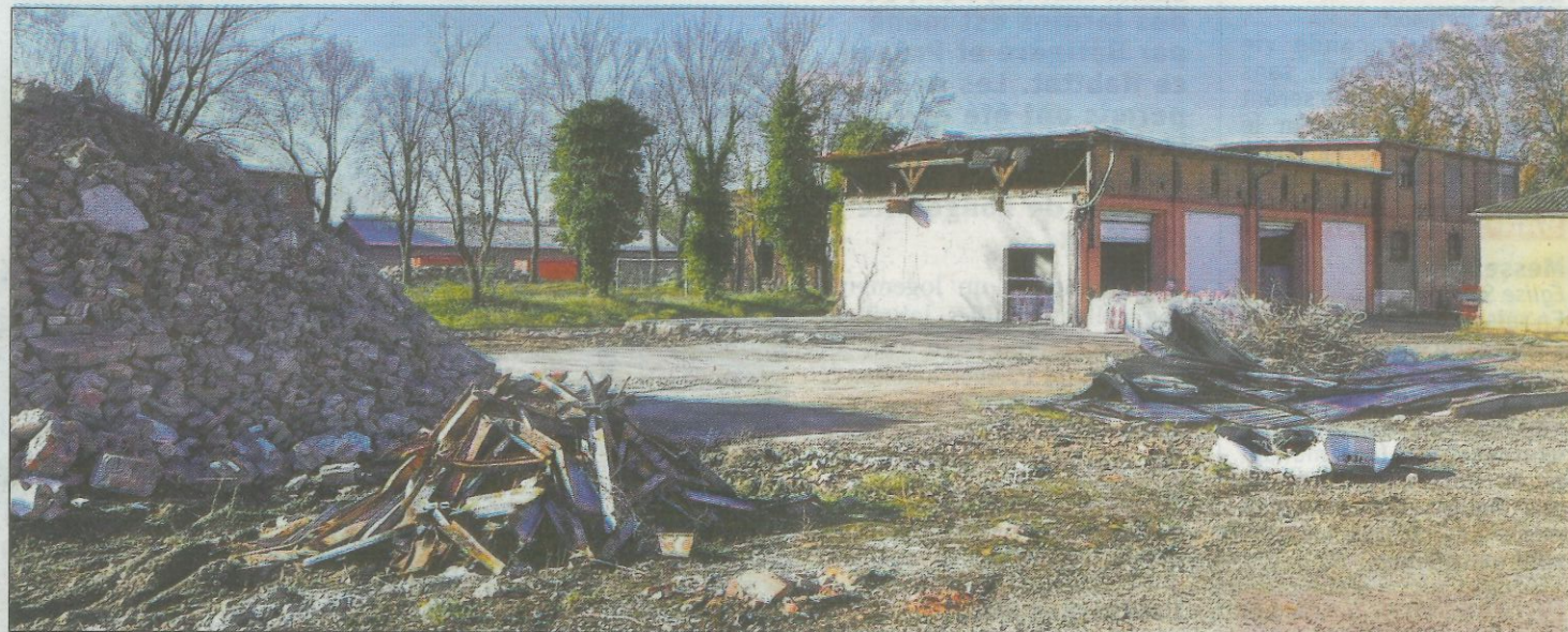
Les matériaux seront concassés avant leur évacuation. Photo RL
