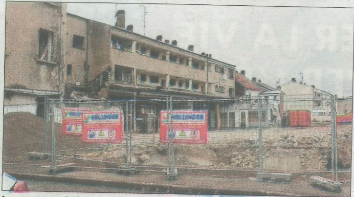
La verrue, côté cour, est en voie de démolition. Photo RL
