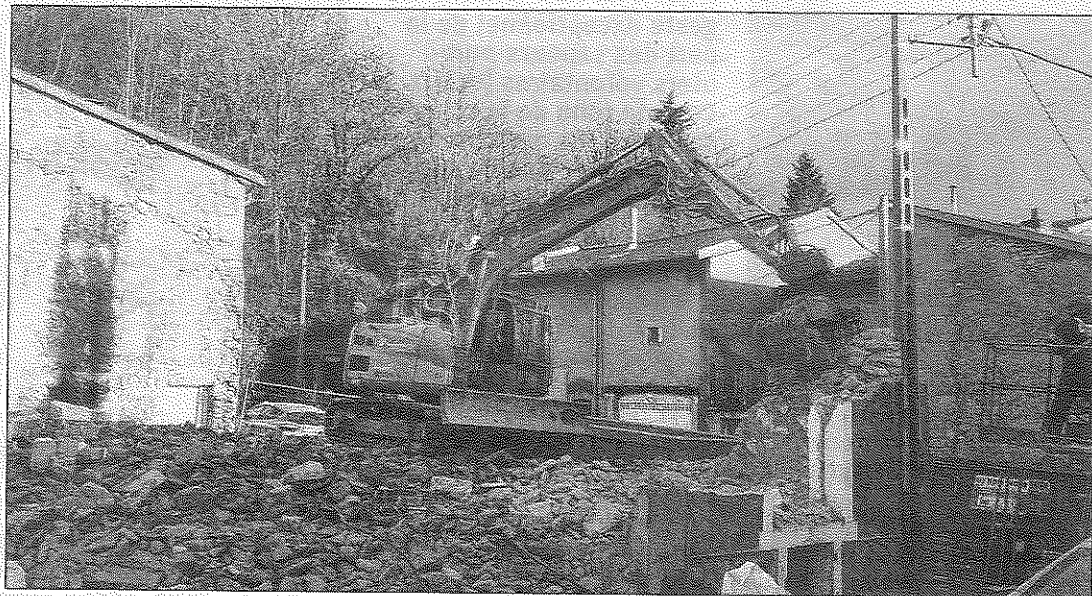
Avec précision, le chauffeur de la pelle mécanique a procédé, au fur et à mesure de la déconstruction, au tri des différents matériaux.
