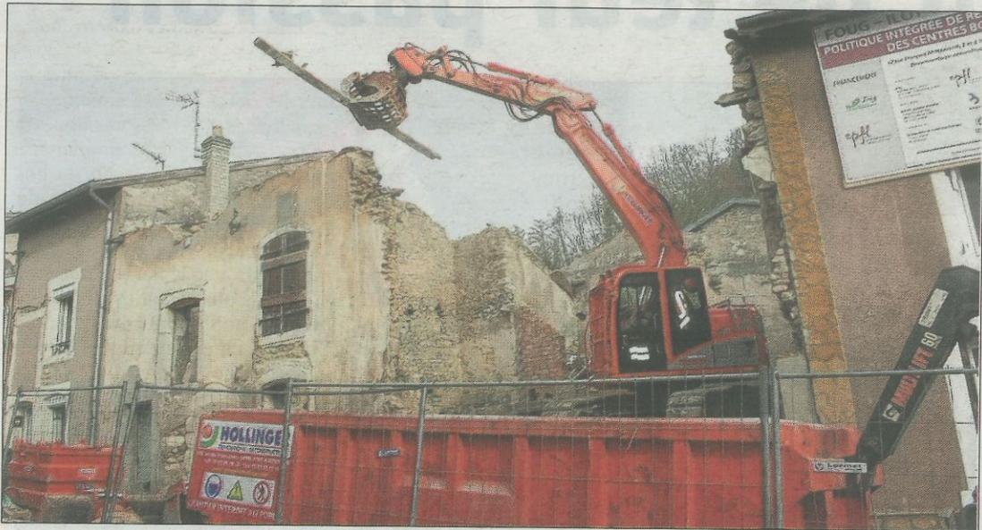
Avec précision et sécurité, le chauffeur de la pelle mécanique procède au fur et à mesure de la déconstruction, au tri des différents matériaux.
