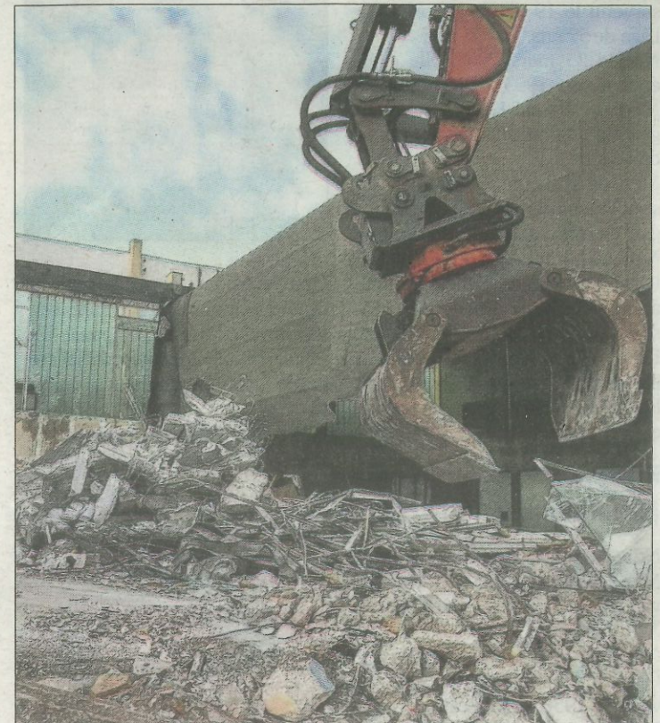
La pelle de démolition n'a guère fait de sentiments.
