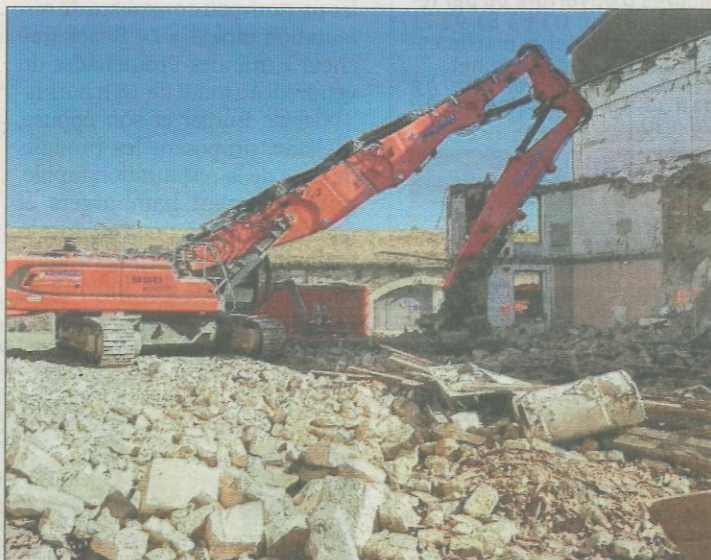
Trois bâtiments sont en cours de démolition afin de préparer le chantier d'extension du lycée Majorelle. Photo ER/Tony ROBIN
