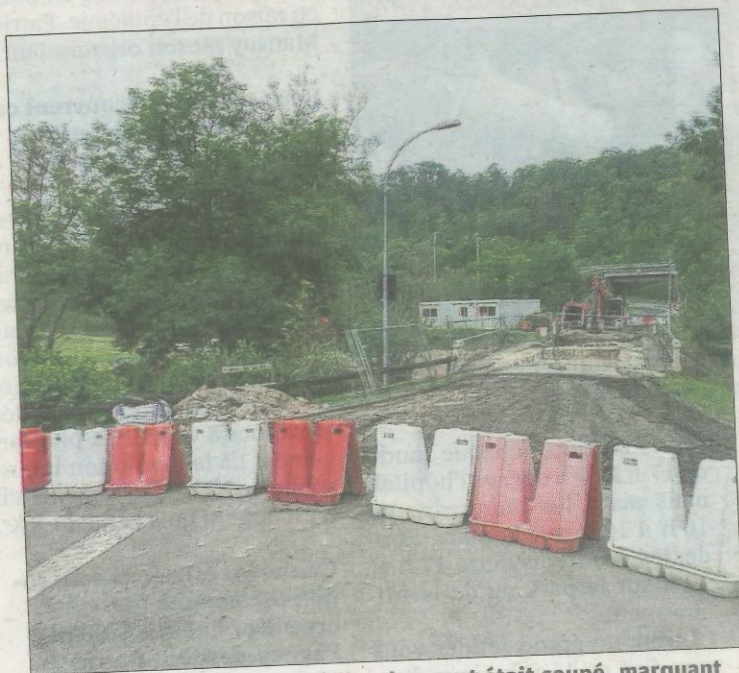
Ce mercredi matin, l'accès à l'ancien pont était coupé, marquant le début d'un important chantier.
