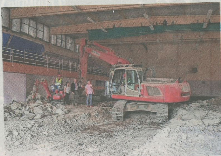
Luc Corradi, maire, Christian Mougin et Nada Aidli, adjoints au maire, ont visité le chantier. Photo RL
