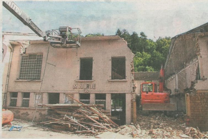
La déconstruction avance bien. Un parking remplacera le bâtiment Photo RL
